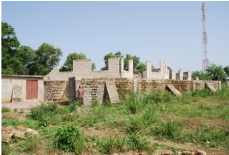
A Prince of Peace gyülekezet épülő imaházának emelkedő falai.
